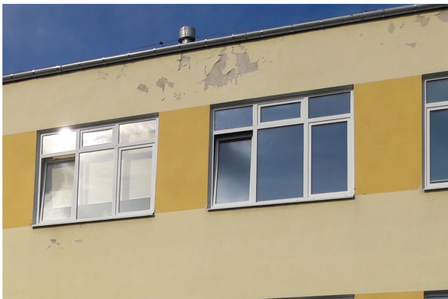
Fot. Łuszcząca farba na elewacji.
