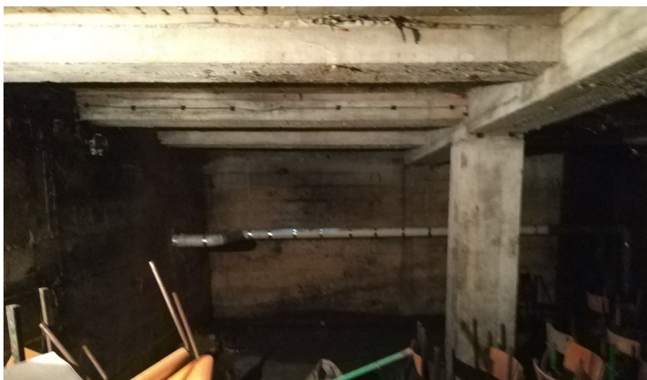
Fot. Strop żelbetowy płytowo-żebrowy w piwnicy.
