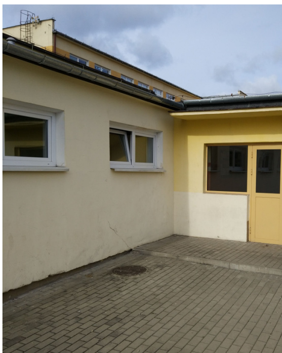
Fot. Zarysowanie ściany zewnętrznej .
